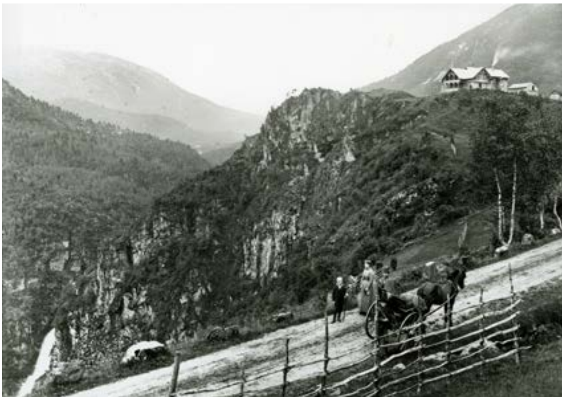
Stalheimskleiva etter at ho blir nybygd i 1840-åra. (Foto Axel Lindahl)
