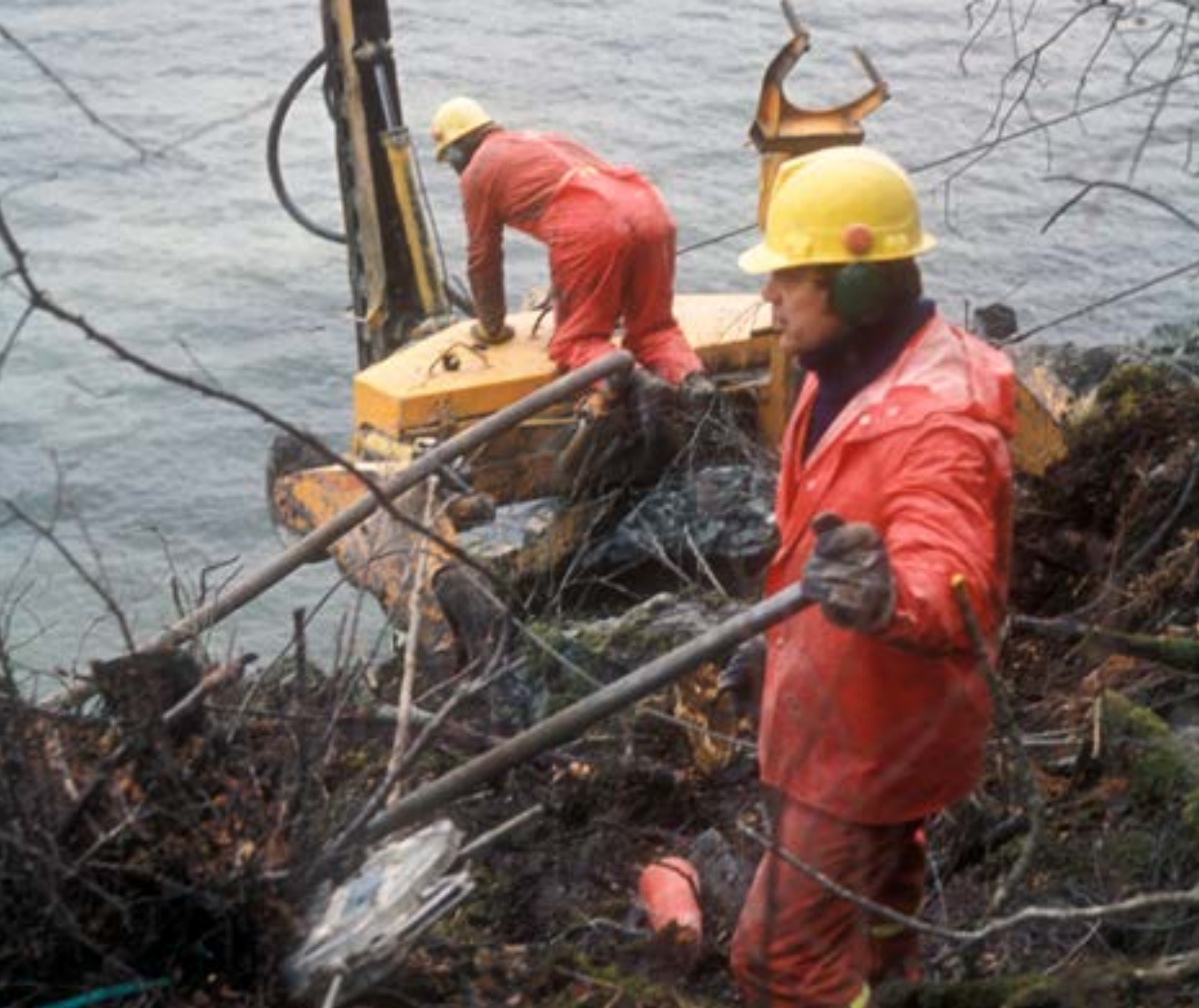
Geita borevogn i arbeid ved sjøkanten etter ras like ved St. Olavs-spranget på riksvei 715, mellom Trondheim og Flakk i april 1982. (Foto: Ingvar Tøndel)
