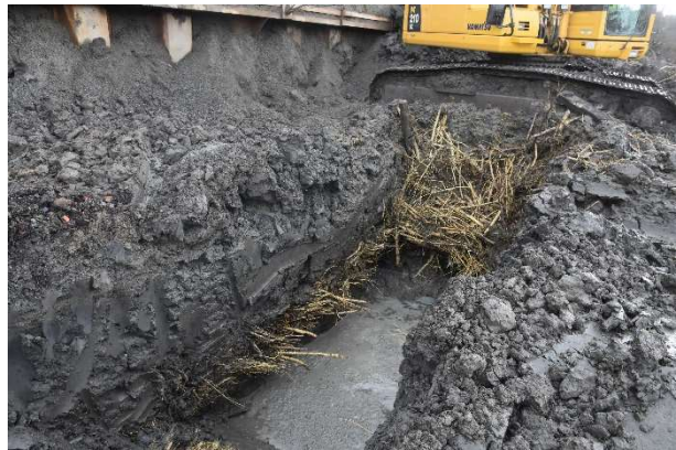
Figur 18: Faskinlager L44 och vatten i schakt 13. Foto mot NÖ av S. Pettersson, NMM.
