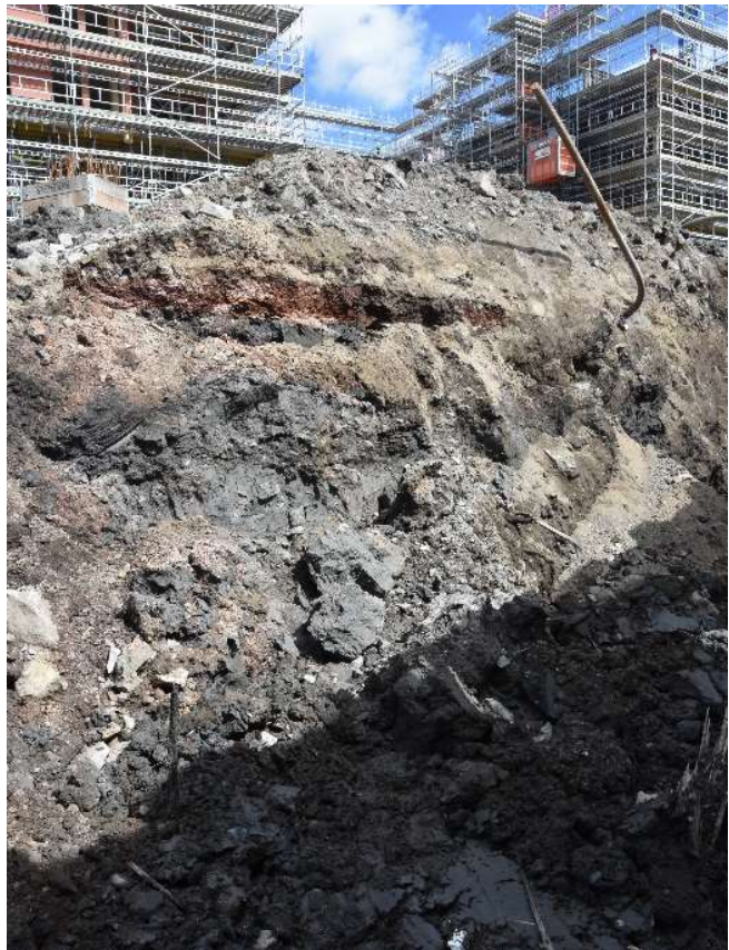
Figur 16: Profil (skisse 12) i den nordöstra delen av tomt B6a. Fyllning med alunskiffer är tydligt markerad som ett röd/orange lins i profilen. Foto mot NÖ av S. Pettersson, NMM.
