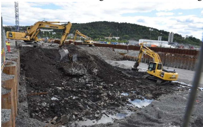
Figur 9: Två grävmaskiner i olika delmoment. Till vänster grävs med tandad skopa ner till ca kote-2, till höger rensas och utjämnas med rak skopa till kote-2,2. Maskinen i mitten är parkerad. Foto mot SÖ av S. Pettersson, NMM.
