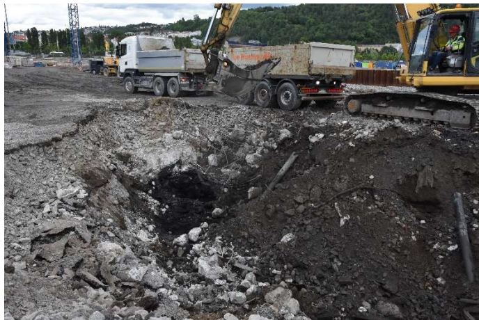
Figur 8: Bilad betong i moderna fyllmassor innan transport. Maskinförare Ole Reiersgård. Foto mot SÖ av S. Pettersson, NMM.
