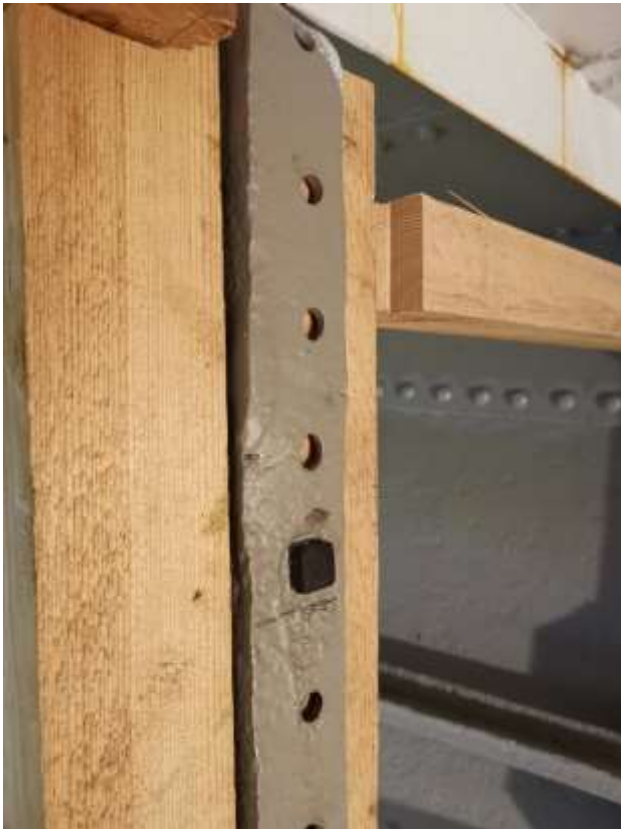
Kopiering av stenderverk. Kjerneved furu. Originale bolter har ligget i olje og brukes igjen.
