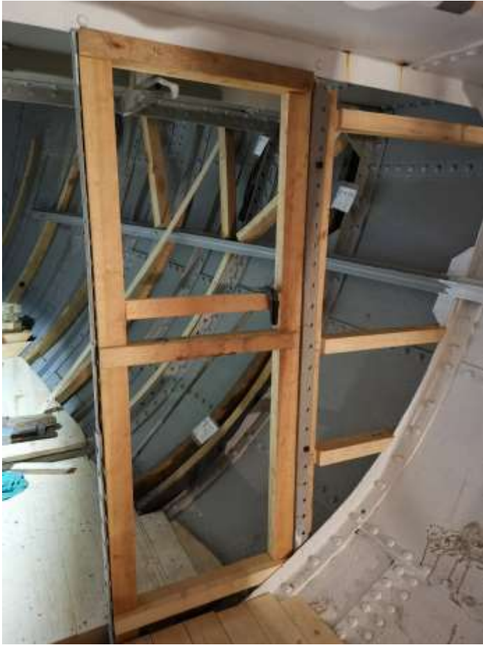
Kopiering av stenderverk. Kjerneved furu. Originale bolter har ligget i olje og brukes igjen.
