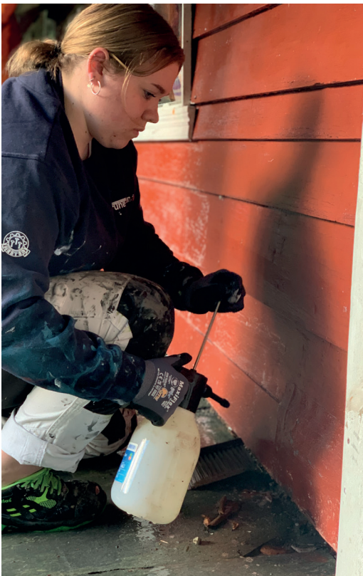
Veggen vaskes alltid først med kraftvask som sprayeres på veggen. Les om fremgangsmåten på neste side. Foto: Fortidsminneforeningen/Lars Erik Haugen
