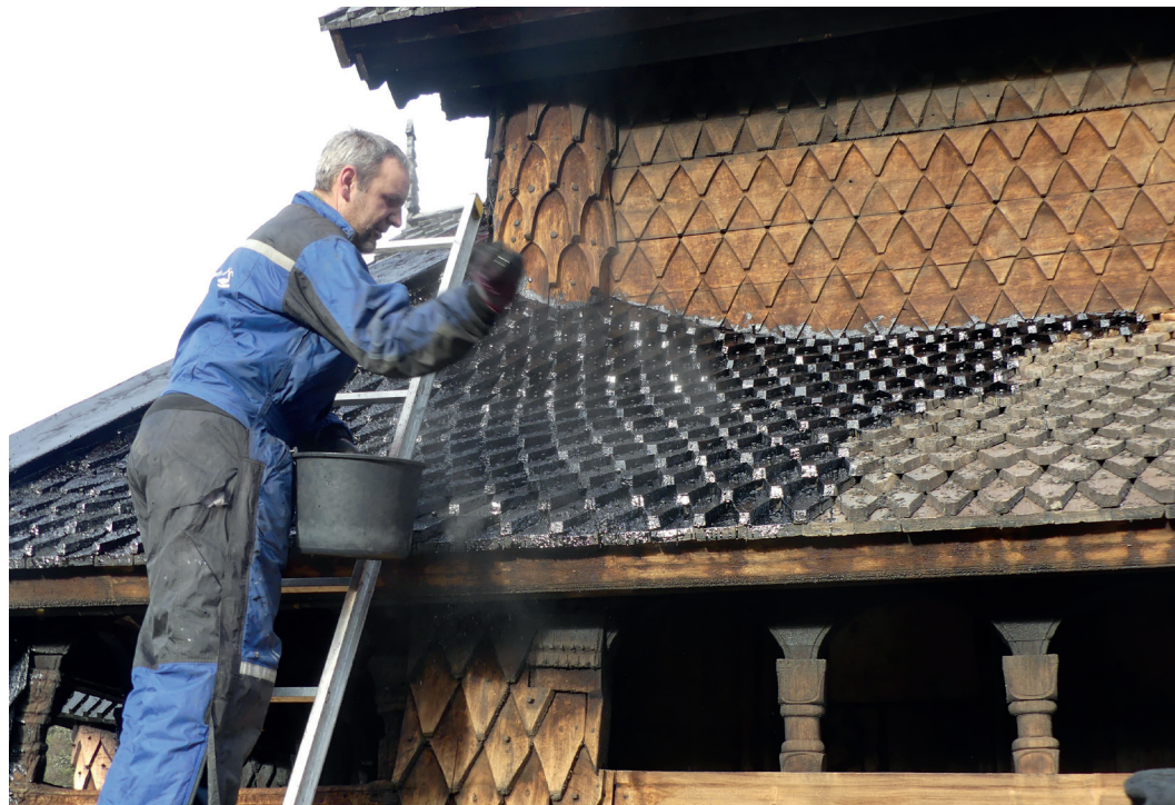
Tjæren påføres varm og breies ut med robuste koster. Det noe ordentlig kliss, så bruk heldekkende arbeidstøy. Foto: Ole Jørgen Schreiner
