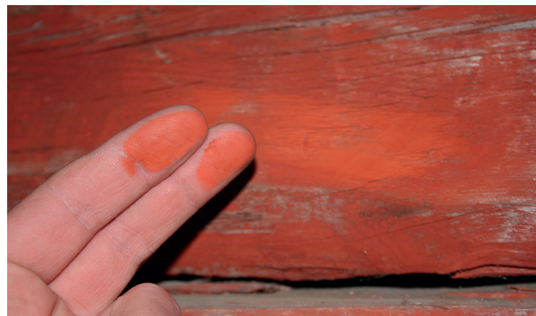
For valg av maling, undersøk alltid hva som er brukt før. Komposisjonsmaling sverter av når du tar på den. Hovedregelen er erstatt likt med likt. Foto: Fortidsminneforeningen/Ola Fjeldheim
