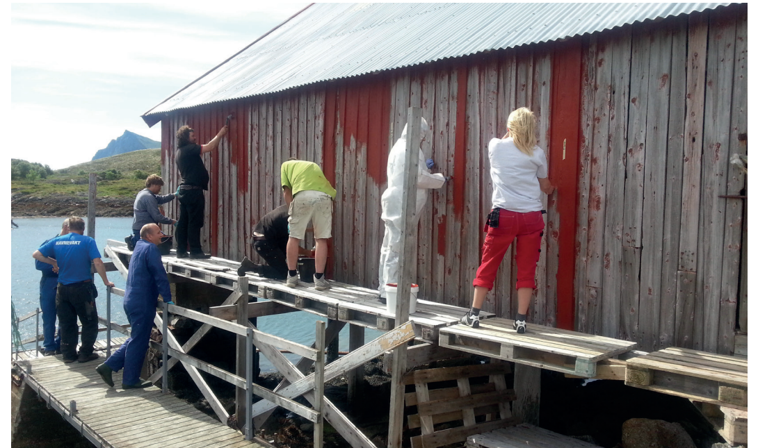
Tranmaling ble tradisjonelt brukt på brygger og sjøhus. Den er behagelig å påføre. Foto: Jon Brønne
