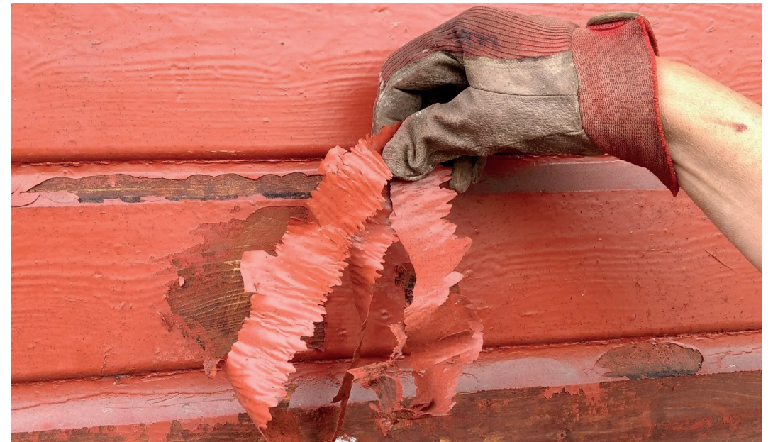
Alkydmaling ble introdusert i Norge for fullt i 1960-årene. Malingen forblir blank på veggen også etter den er tørket. Foto: Gamletrhus.no
