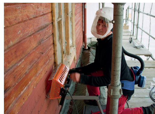
Når eldre malingslag skrapes vekk er det viktig med riktig sikkerhetsutstyr og åndedrettsvern. Maling kan inneholde stoffer som er skadelige for oss når de løsnes. Foto: Georg Mathisen, maleren
