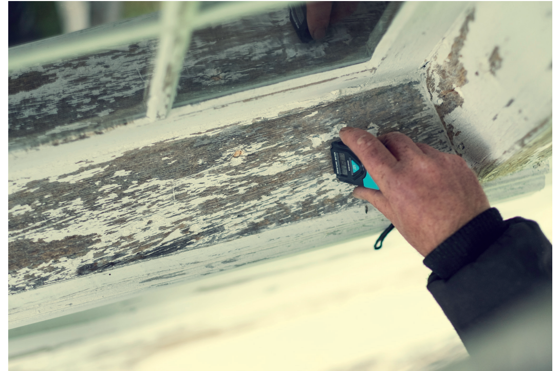
Veggen må være helt tørr når du skal male. Mål fuktinnholdet med en fuktmåler. Foto: Fortidsminneforeningen/Bård Gundersen
