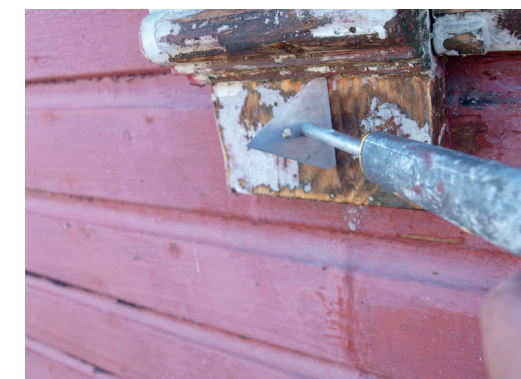
Skraping krever godt verktøy. Skraper kommer i ulike former tilpasset profiler og kriker og kroker. Foto: Gamletrehus.no
