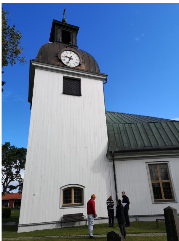
Tornet efter arbeten samt hörnet där det fanns en rötskada bakom stupröret och en liten bit av panelen ersattes.
