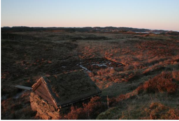
Figur 3.2.G. Her er moldtaket ein måned etter at overflatelaget var fjerna. Foto: Trine Årstøl 29.11.10
