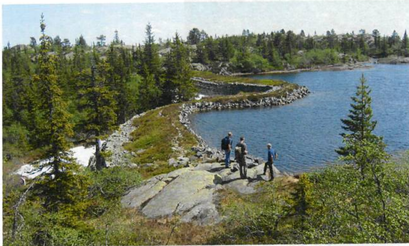
Stordammen (723 m.o.h.) er den nest største dammen. De tre største dammene krever sikkerhetstiltak iht. vassdragsforskriften. For tiltak og vedlikeholdsarbeider ved Stordammen, Kongensdam og Kongensdamsrenna er det et betydelig transportbehov for stein, torv og maskiner. Fremføring av vei gjennom det åpne landskapet hit er nå diskusjonstema.
