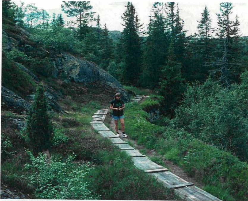
Kongensdamsrenna, bygd sommeren 1776. Av totalt ca. 50 km vannrenner blir ca. 9 km vedlikeholdt og fører vann. Fra 1957 til ca. 1985 brukte Kongsberg kommune vannsystemet som byens drikkevannsforsyning.
