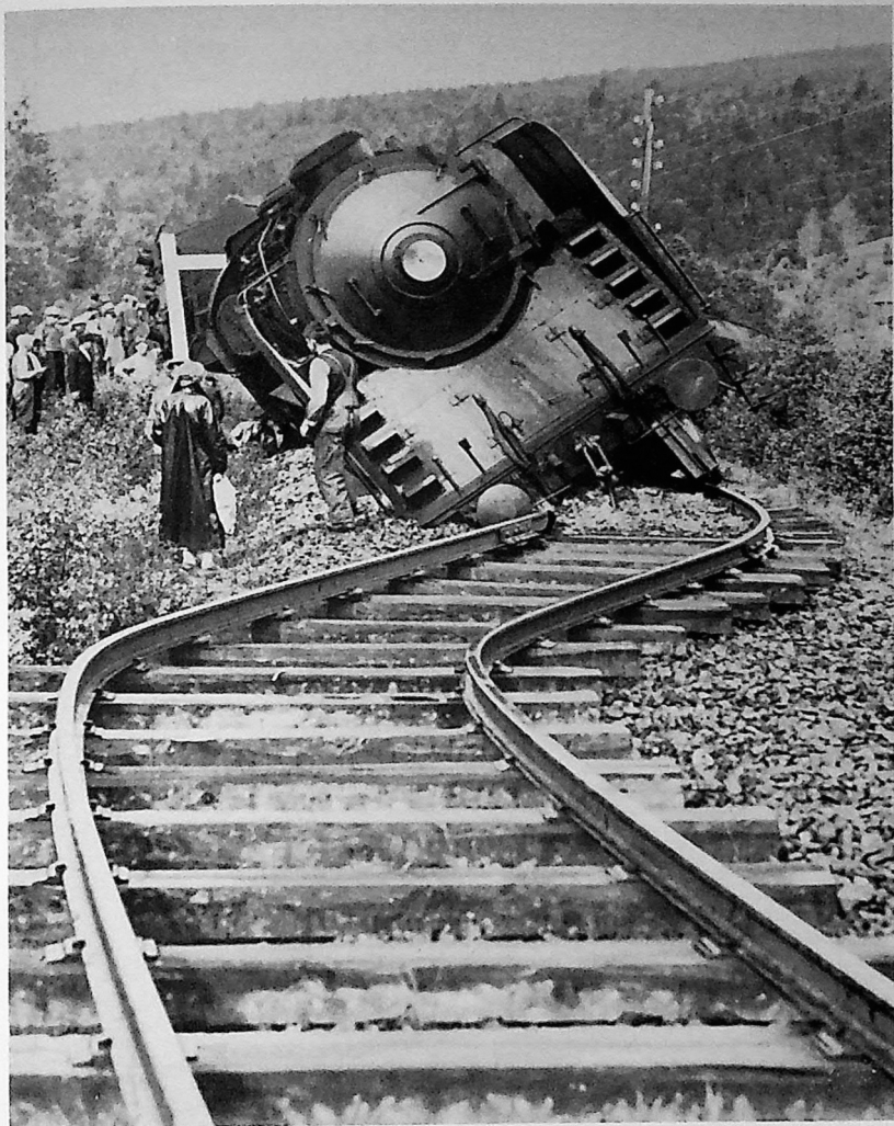
Dovregubbe nr. 465 efter avsporingen mellom Garli og Berk- åk stasjoner på Dovrebanen 16. juni 1936, altså samme år som lokomotivet ble levert.
