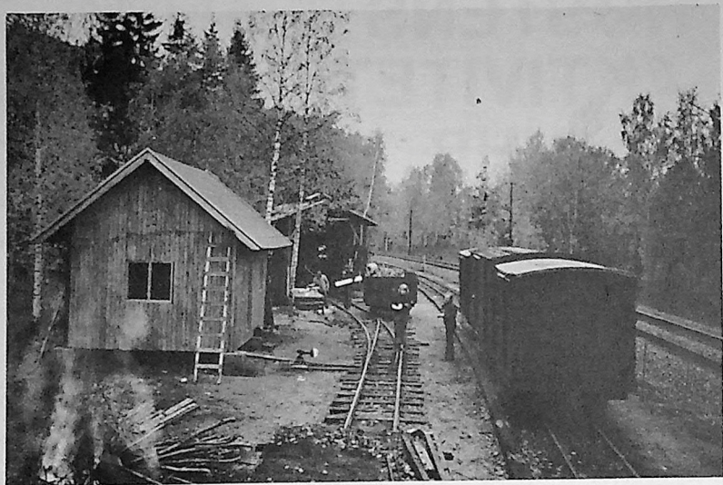
Arbeidsdag på Bingsfoss lørdag 11. oktober. Panelingen av stasjonsbygningen utvendig fullføres, mens trærne fra vognhallområdet brennes og generell opprydding pågår. (Foto: P.Tallaksen)
