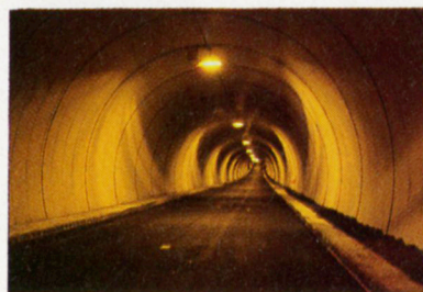
Tunneltaket sikres med platehvelv.
