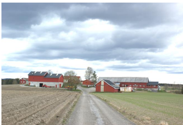
Driftsbygningen på Næss østre til høyre på bildet. Stedet ligger på Skavangen, et nes uti nordre del av Einafjorden.
