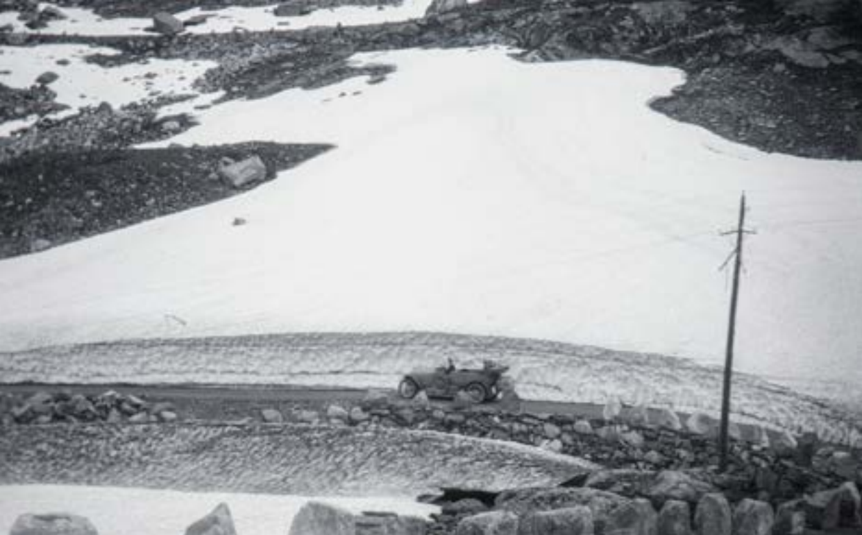
Det var i Hans Hagerup Krag's tid som vegdirektør at hele Haukelivegen over fjellet ble ferdig. Arbeidet startet i 1857 og ble ferdig i 1889. Her kjører en rutebil med passasjerer forbi Dyrskar rundt 1920.
