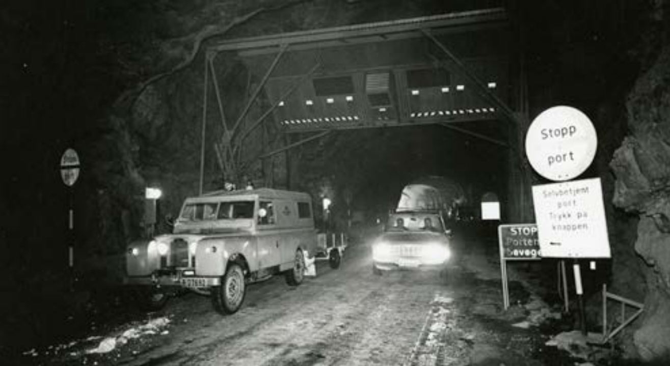
Tunnelene fra 1968 var trange og mørke. Ved enden av Haukelitunnelen var det satt opp en selvbetjent port som skulle hindre fuktig luft i å komme inn og fryse inne i tunnelen.
