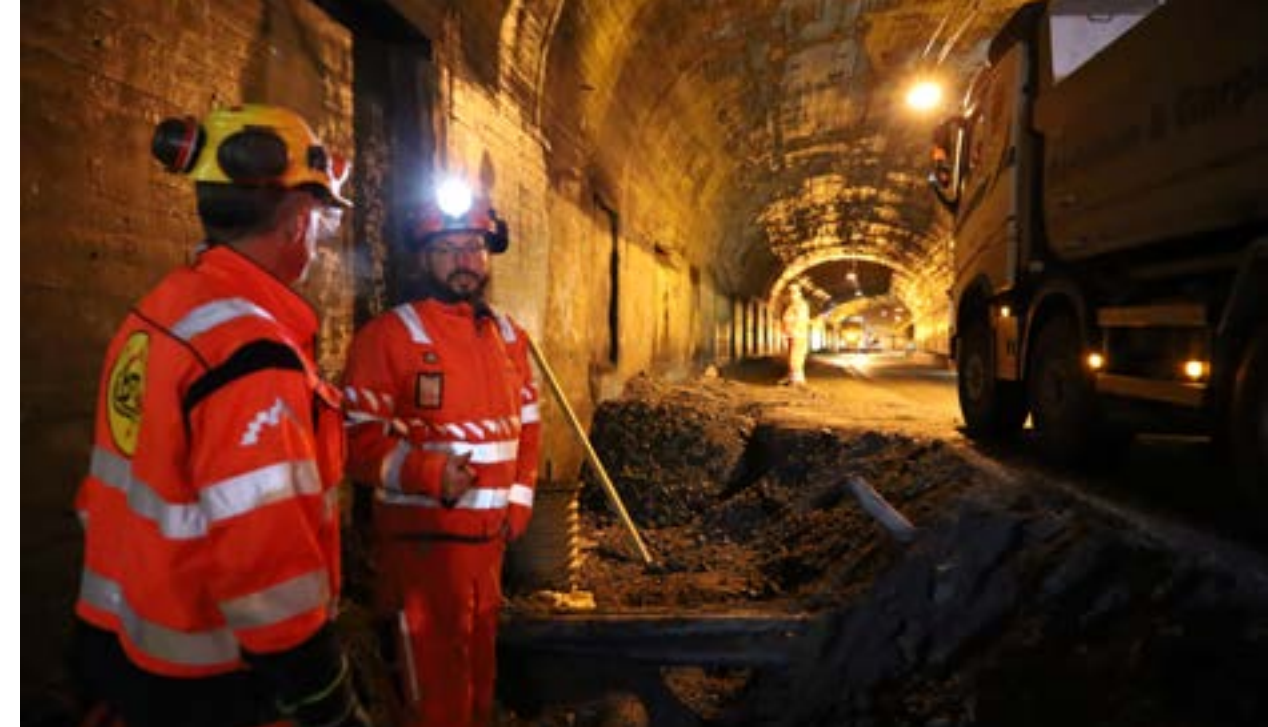
Tunneloppgradering innebar blant annet modernisering av dreneringen under asfalten. Her Jarle Johnsen og Jon Bjarte Allmenningen Rasmussen i arbeid. (Foto: Håkon Aurlien)
