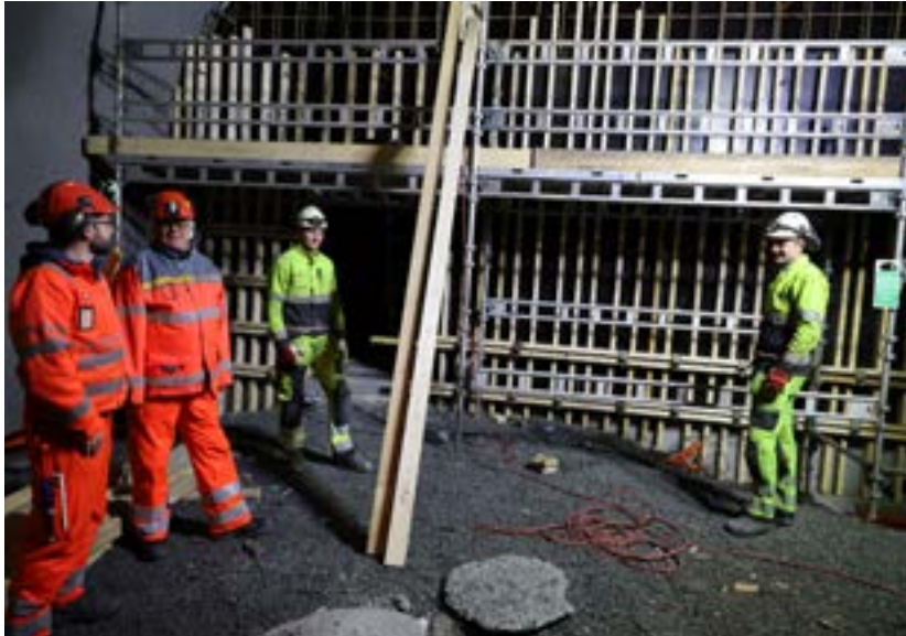
Tunneloppgraderingen de siste tre årene har vært omfattende. Fra venstre ingeniør Jon Bjarte Allmenningen Rasmussen, Lars Helge Rasch som var kommunikasjons-tilrettelegger for prosjektet, og Sjur Jøsendal og Hogne Røneid fra entreprenøren Høyer Odda, i gang med betongarbeid. (Foto: Håkon Aurlien)
