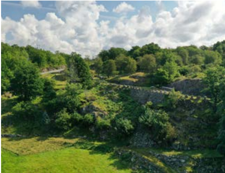
Gjennom Rodvelt går den gamle veien som var i bruk mellom 1889 og 1954 som et levende veimuseum. Helt til venstre i bildet skjærer 1954-veien rett frem. (Foto: Tore H. Wiik)
