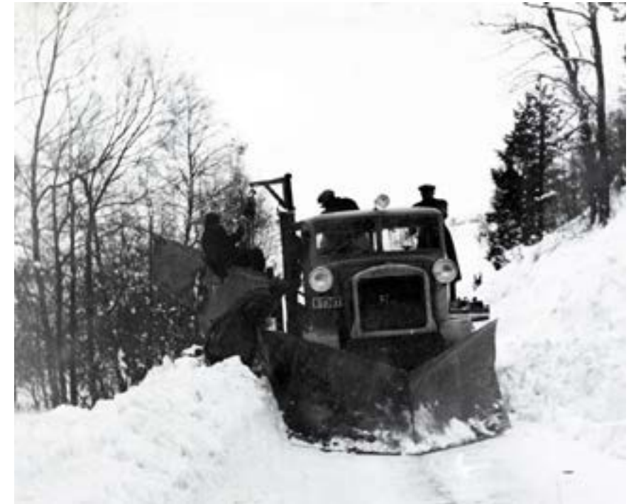
En 1936 FWD brøytebil er i arbeid på vei mot Hotell Utsikten en vinterdag tidlig i 1937. Jonny Colbjørnsen, importør av FWD, er på besøk for å se ny kantving laget til FWD på Vegvesenets verksted på Liknes. (Foto Leiv Strand/Statens vegvesen)
