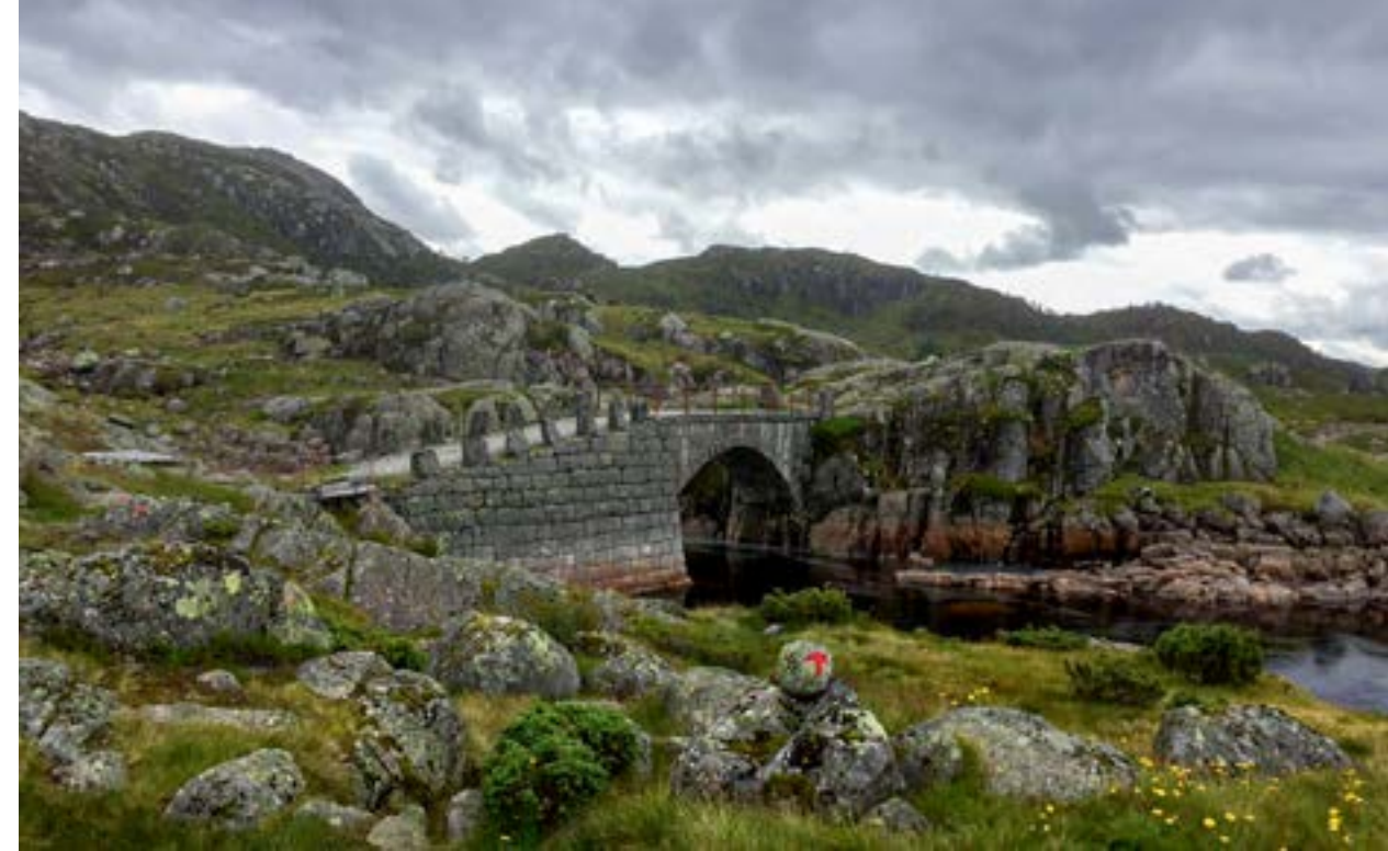
Kvina bru har ingen veiforbindelse, men var ment til å bli en viktig del av den planlagte Riksvei 10 som skulle gi rask forbindelse mellom Oslo og Stavanger. (Foto Fredrik Jonsson)
