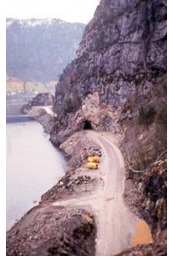
Dagens E39 bruker fortsatt den gamle jernbanetraséen langs Lundevannet. Hele syv tunneler måtte forbedres. To er gjort om til skjæringer, fem har fått en god standard. Bildet til høyre viser forbedringsarbeider nær tunnel nr. 5 sørfra i 1967. Det er tatt fra toppen av tunnel nr. 4 som nå er borte. (Foto fra Norsk vegmuseum). Det andre bildet viser en langt bedre vei i 2022. (Foto: Tore H. Wiik)
