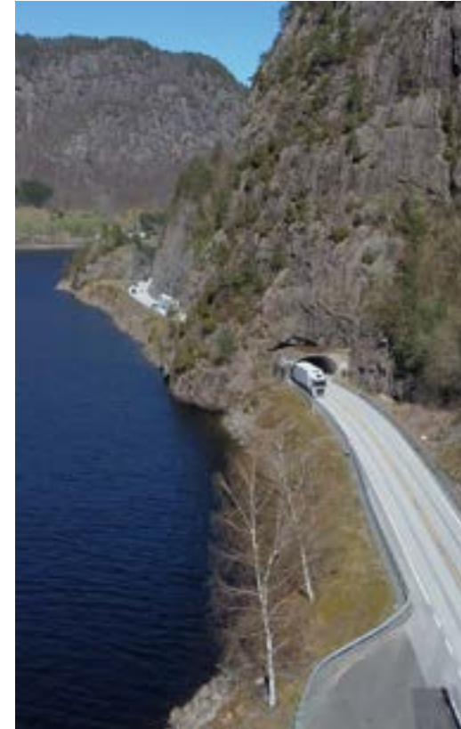
Dagens E39 bruker fortsatt den gamle jernbanetraséen langs Lundevannet. Hele syv tunneler måtte forbedres. To er gjort om til skjæringer, fem har fått en god standard. Bildet til høyre viser forbedringsarbeider nær tunnel nr. 5 sørfra i 1967. Det er tatt fra toppen av tunnel nr. 4 som nå er borte. (Foto fra Norsk vegmuseum). Det andre bildet viser en langt bedre vei i 2022. (Foto: Tore H. Wiik)
