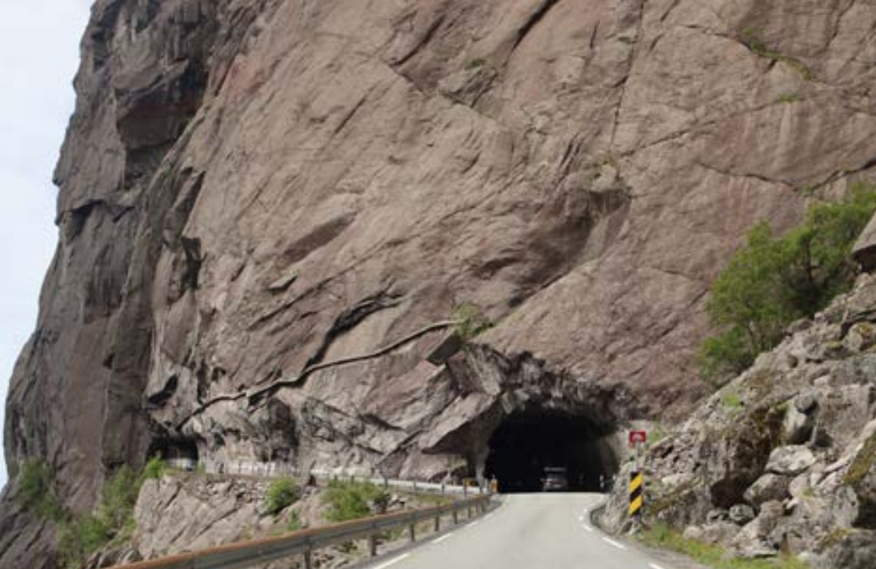
Utfordrende terreng her ved Jøssingfjord. Veien gjennom tunnelen til venstre, var ferdig i 1921. (Foto: Tore H. Wiik)
