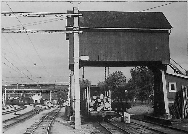
Portalkranen kan knapt kalles et vakkert byggverk, men den utførte et nyttig arbeid. Legg merke til opphalingspillet mellom sporene. Foto: Jan Lysaker
