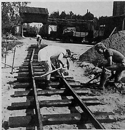
Kranen i sikte!
