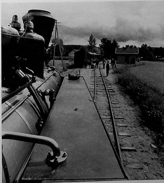
Dagens UHB stopper etter 4 km. på Fossum. Her mangler en bro over riksveien, men vi skal da videre!!!
