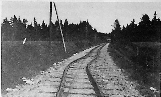
Etter streiken i 1931 måtte det omfattende vedlikeholdsarbeider til. Banen sto fra 27. april til 6. august, og da streiken var over tro samtlige til, og hjalp til med utbedringsarbeidet. (Foto: Eigil Prydz)
