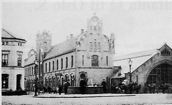
Byens første stasjonsbygning var tegnet av arkitektene Schirmer og von Hanno. Den ble oppført i 1854.
