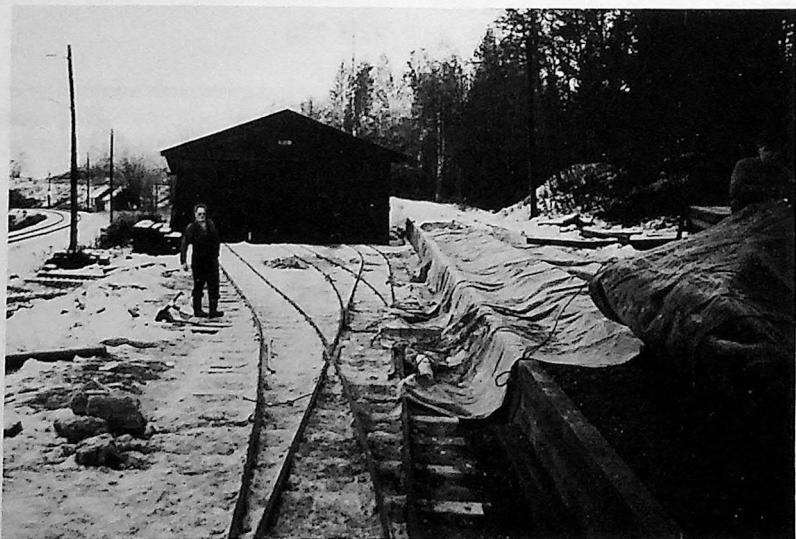
Disse to bildene er tatt i hver sin retning ved vognhallen på Bingsfoss, og viser tydelig arbeidene som er gjort der. Vi ser støttemuren, og den meget forbedrede kurvaturen til vognhallssporene. At sporprofilen nå er kraftig forbedret, gjør at vi kan plassere boggivogner på alle tre spor i hallen. (Foto: Bjørn Haavaldsen)
