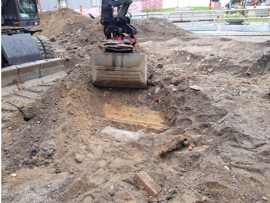
Figur 3. Tidigt under schaktningen noterades det övre raseringslagret, SL200, troligen av rivningsmassor från "Södersaneringen". På bilden syns också störningen, SZ201, i form av ett nedgrävt rör. Foto: Frida Löjdström, mot sydöst.
