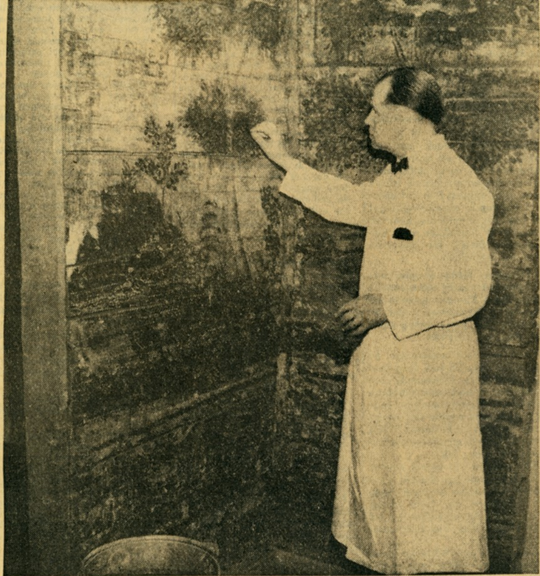
Konservator Bertil Bengtsson i arbete med att restaurera ett av väggfälten.
