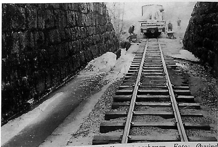
Banearbeid i undergangen til Kongsvingerbanen. Foto: Øyvind Hofseth
