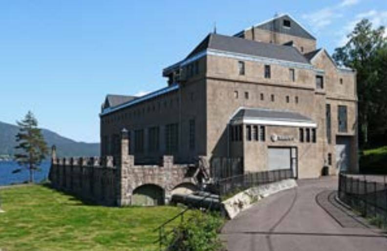
Hakavik kraftstasjon i 2021. (Foto Morten Reiten)
