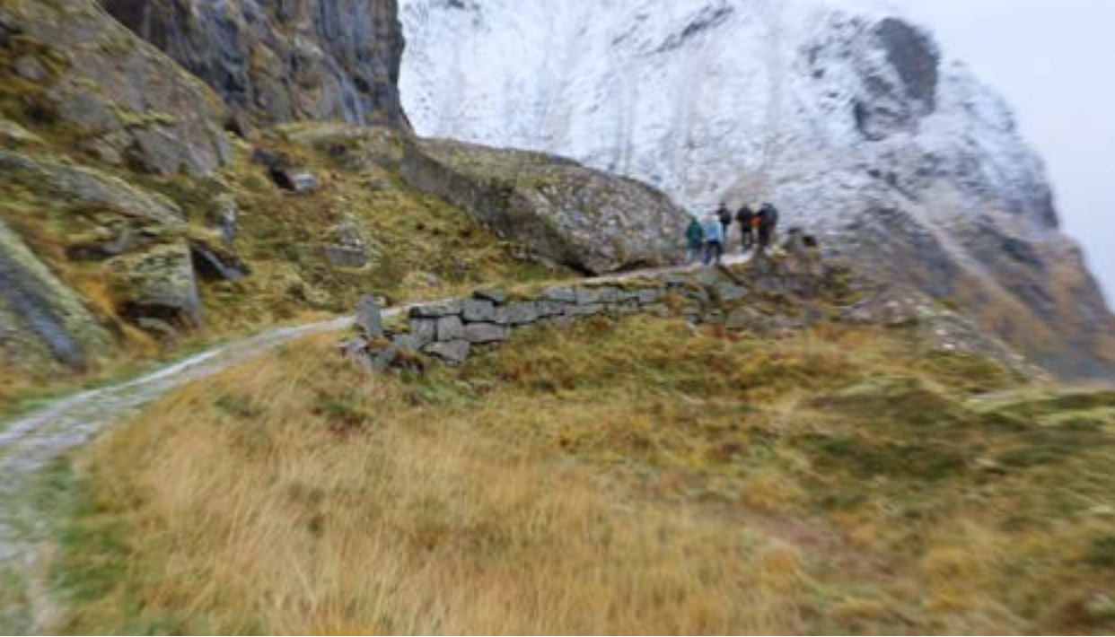
Kjørevegen over fjellet ble bygd i 1902 og innebar at hestevognene måtte forsere bratte bakker. Slik var det inntil bilvegen rundt sto ferdig i 1947. Restaureringen av den gamle vegen dreiet seg mye om å åpne grøfter og gamle steinrenner. Fire sherpaer fra Nepal har brukt unik steinkunnskap i arbeidet med istandsettingen. Olav Rebni i Stibyggjaren AS (til høyre) har organisert arbeidet. (Begge foto: Håkon Aurlien)
