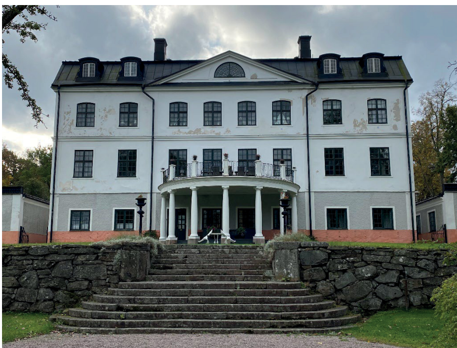
Figur 6. Forsbacka herrgård sedd från norr efter avslutade arbeten. Inom detta projekt har fönsterbågar i fasaddelens andra och tredje plan byggts om. Foto: Ulrika Olsson, 2021-09-28.
