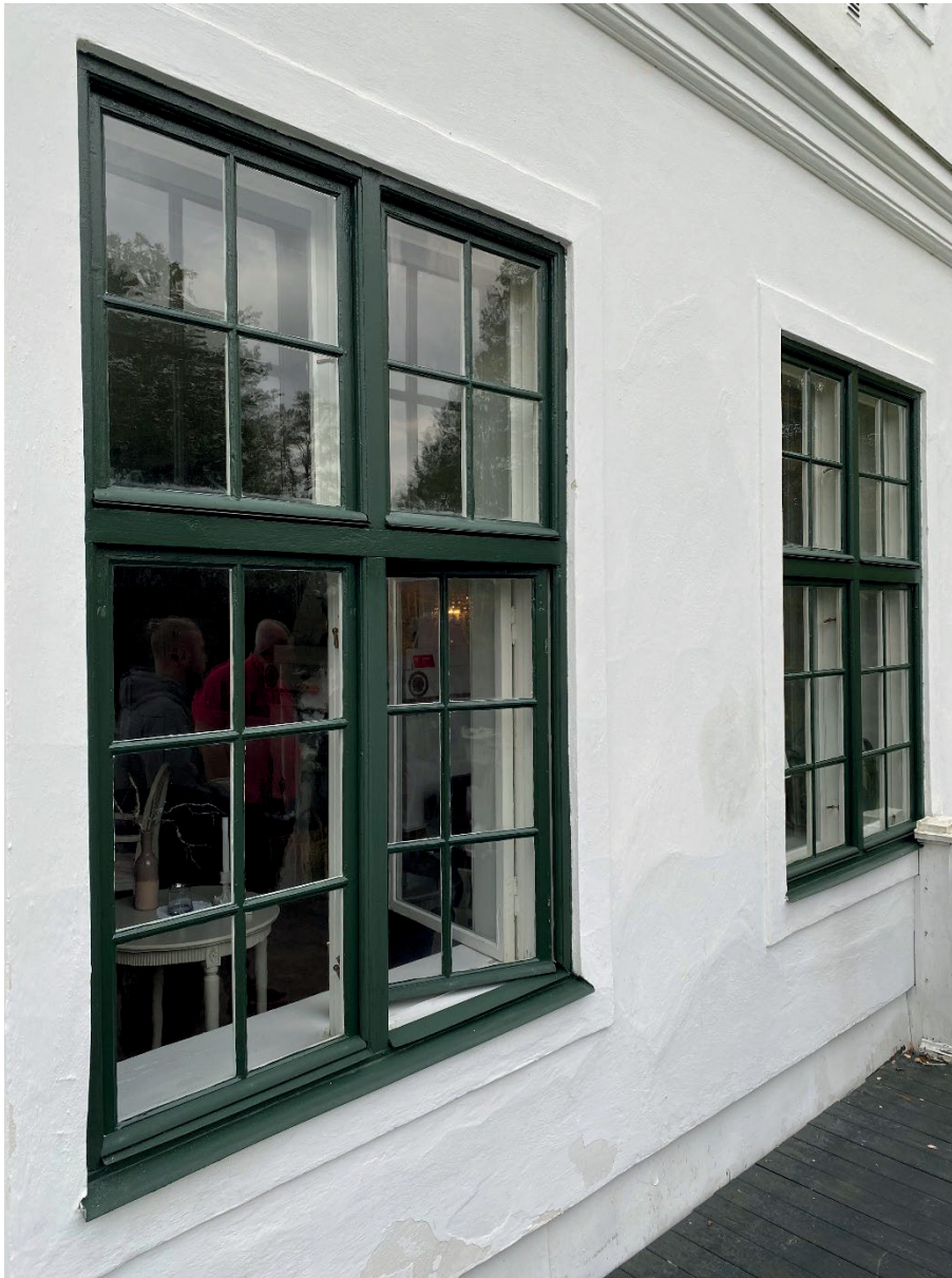
Figur 7. Två av fönsterenheterna på balkongplan efter avslutade arbeten. Foto: Ulrika Olsson, 2021-09-28.
