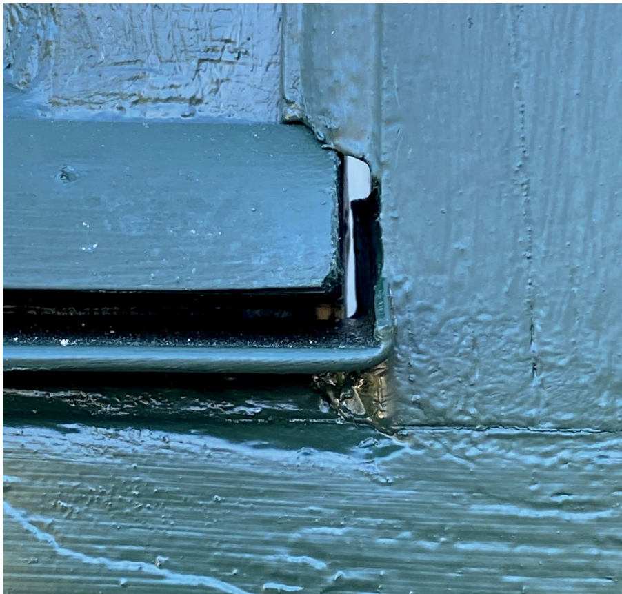
Figur 8. Närbild på en glipa in mot mittposten. Foto: Ulrika Olsson, 2021-09-13.
