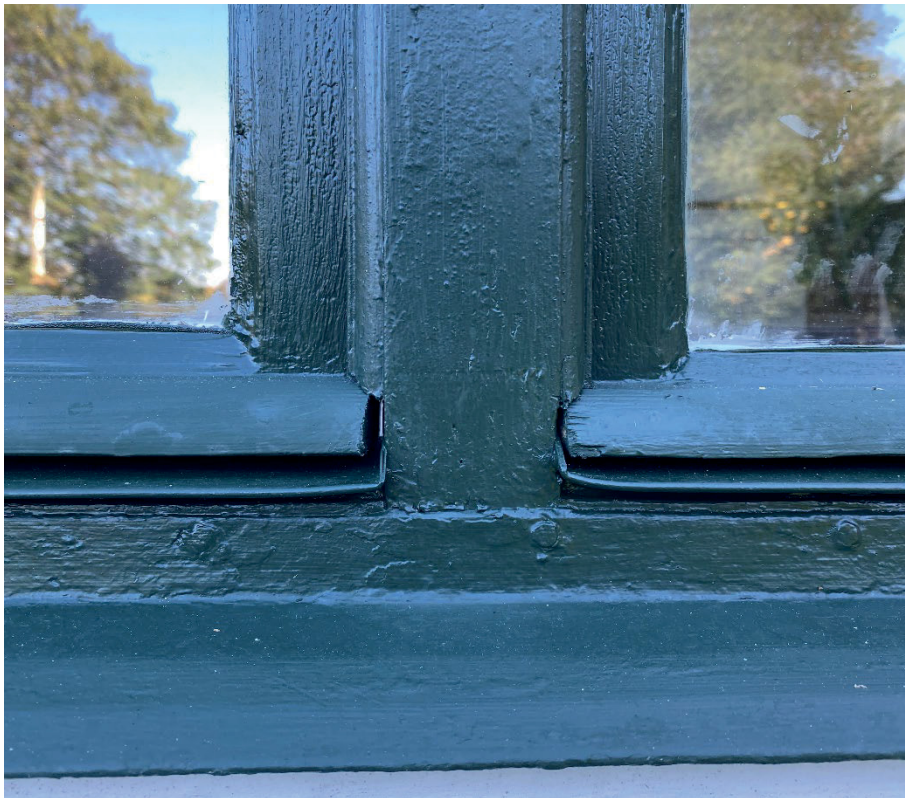
Figur 3. Åtgärdade bågar. Bytta droppnäsor med längre utskjut samt nya plåtbleck som ytterligare råd över karmbottenstycket. Foto: Ulrika Olsson, 2021-09-13.
