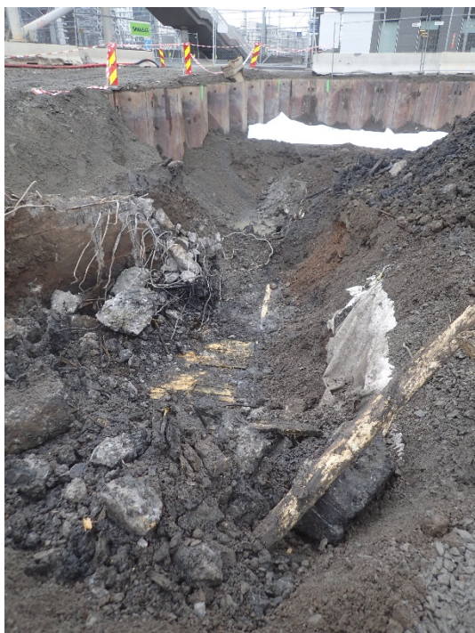
Figur 20: Grøft 4 med treverk under betongkulvert. Foto. K. Bortheim/NMM.
