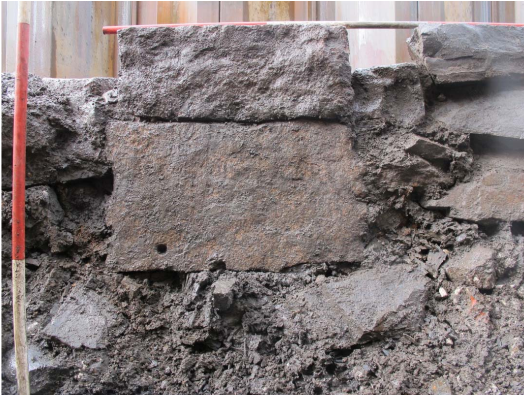
Figur 23. Steinblokker i K1. Sett fra utsiden, mot vest. (Foto NMM).
