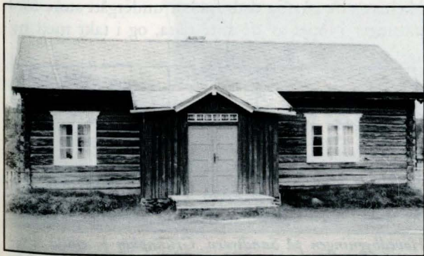
Østerdalsstua på Sandtrøen, fotografert i 1993. På gamle bilder kan vi se at stua tidligere hadde bordtak. Den gamle svala er erstattet med ny. Ellers står huset som det var.
