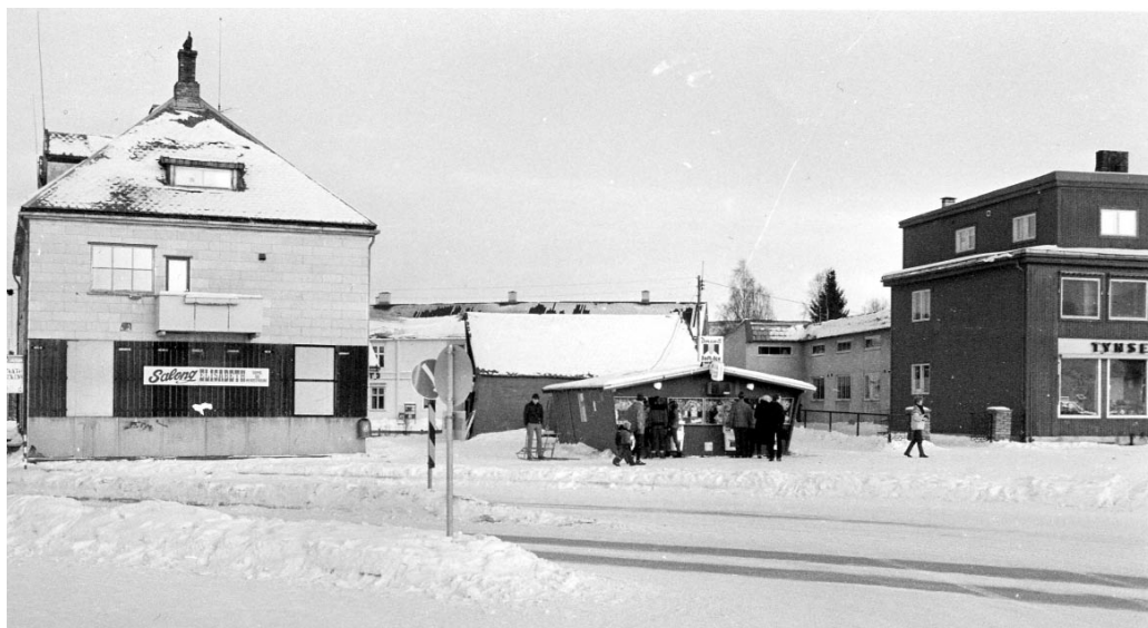
Kiosken sentralt mellom Moengården og Maskinforretninga.
