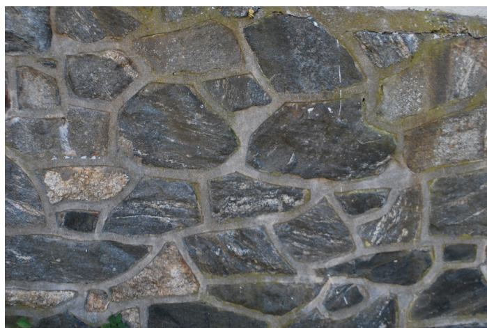
Huggen stedlig stein med utenpåliggende fuger
