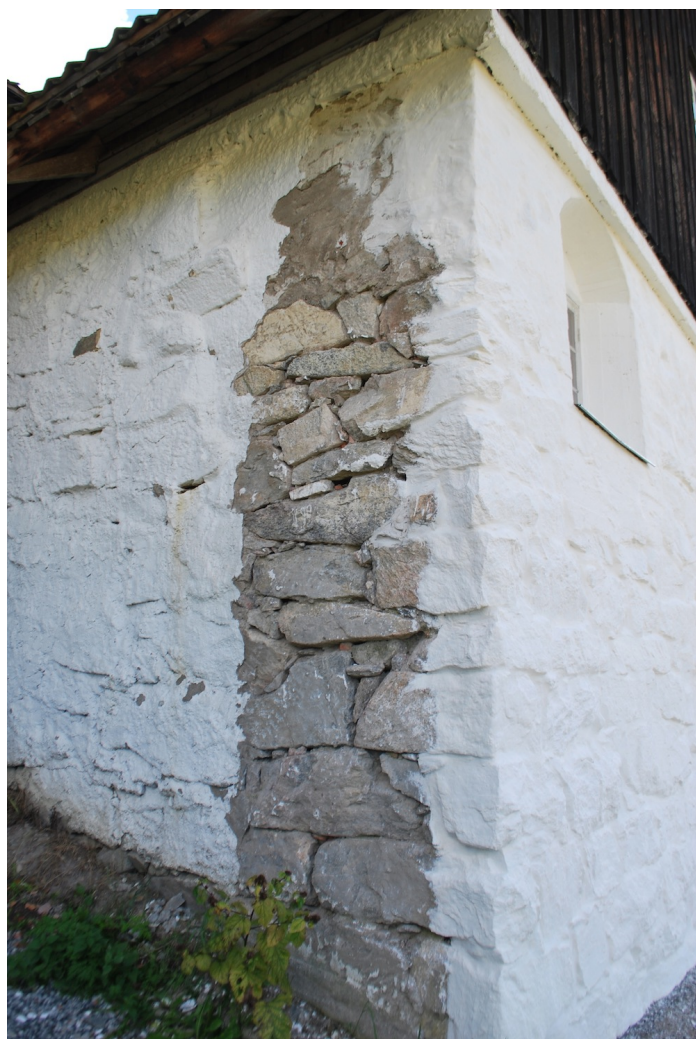
Tre faser i arbeidet: sprøytebetong, rengjort fasade og ferdig restaurert.
