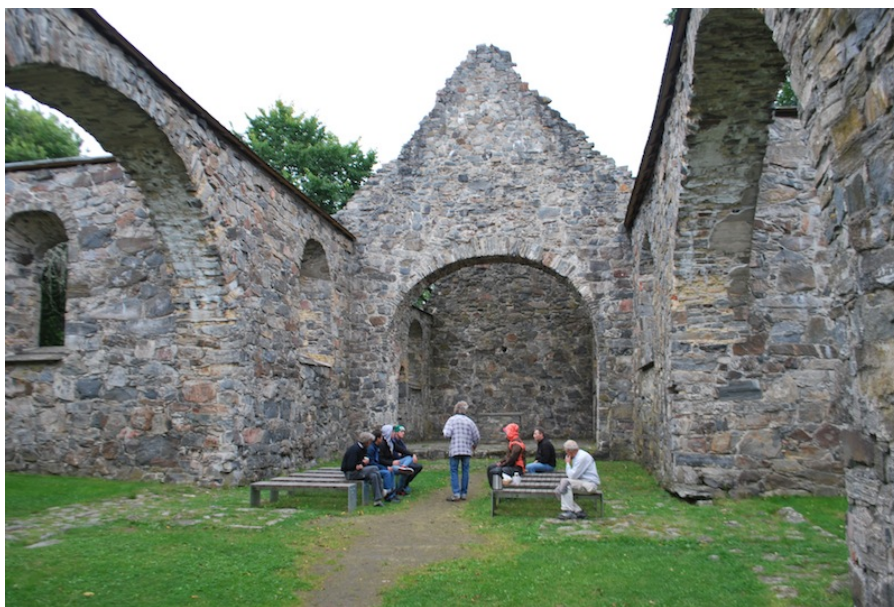
Fra skipet i Nes Kirkeruin. Historisk gjennomgang av kirkeruinens utvikling og byggemåter
