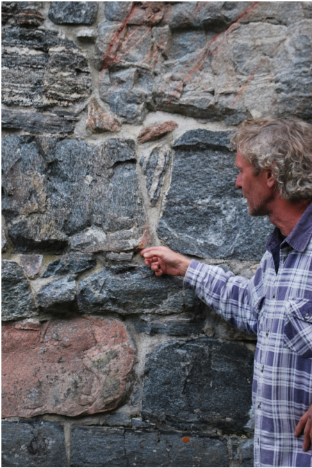
Murermester Terje Berner forklarer sementfugenes skadeeffekt på kalkmørtelen i murverket
