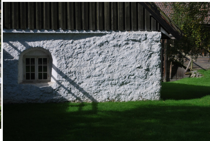
Th. fasade med sprøytebetong.
