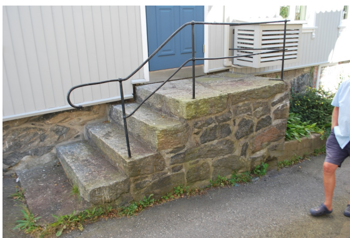
Stein med forskjellig bearbeidingsgrad i trinn og vanger
