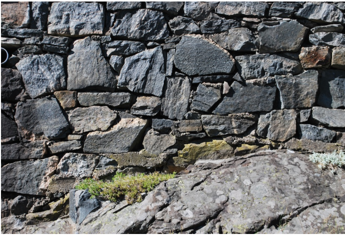
Sprengstein murt mot forskaling og bakstøp
