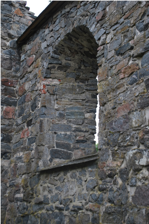
Stor grad av ubearbeidet stein og sementfuger. Merk steinsettingen i vindusbuen.
