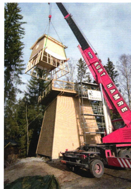
BRANNVAKTTÅRN To nye attraksjoner er under bygging på museets uteområde. En kopi av et brannvaktårn fra Haukenesfjellet i Østfold. Elveparken bygges i samarbeid med Norges vassdrags- og energidirektorat.
