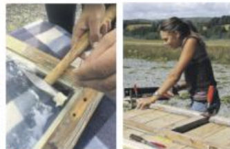
RÅTE: Er det i størkader i treverket har dette ervidtes av nytt, friskt og tørtvokt trevirke. På bildet ser lederen Henriette Grøndahl med restaureringen av et av hennes gamle vinduer. FOTO: PRIVATMOBEKK, HENRIETTE GRØNDALH
