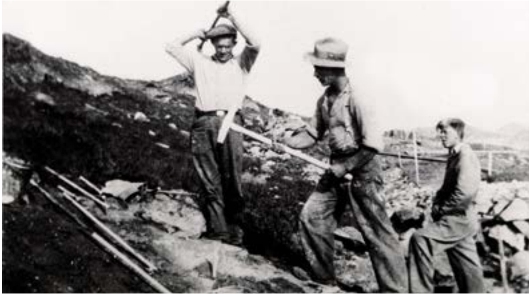
Tunnelbygging vart utført av røynde sluskar, men i 30-åra vart fleire vegar bygde som sysselsettingsveggar. Biletet er fra rv 55 Sognefjellsvegen, der (frå v) Håkon Meldal, Olav Hellem og Ola Olstad bygger ei fjellskjering ved Fante-steinsvatnet.
