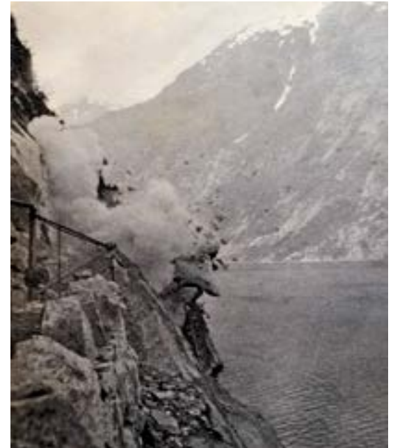
Salva går på veganlegget Tyssedal - Espe i fjellsida ned mot Tysse-dalsvatnet, i juni 1922.
