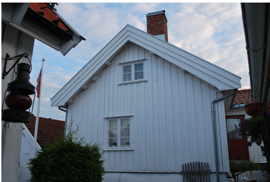
Tidlig 1700-talls åstakshus som har fått 15-20 cm isolasjon over det gamle bordtaket. Huset har mistet sine proporsjoner. Tradisjonelt er det to vindskibord, ca 27 cm brede.
