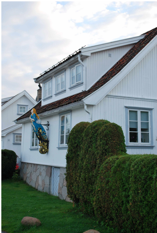
Et tidlig 1800-talls hus med rett takflate ble til svaitakshus etter at vegger ble isolert utover og vinduer skiftet. Muren har fått ny forblending.
