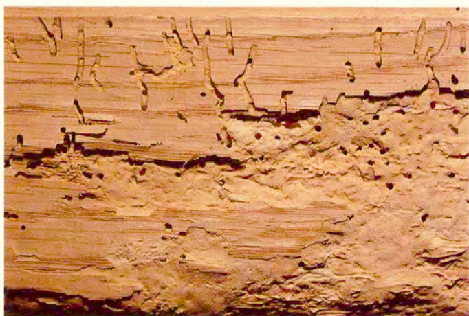
60. Skada på ekparkett orsakad av parkettbaggen.
