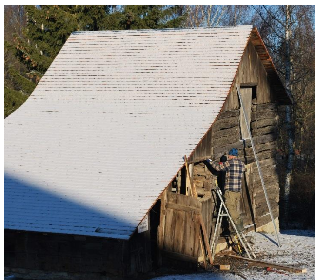
Håndverker og tømrer Sigurd Fuglseth og Leif Arne Holen i arbeid på låven.
