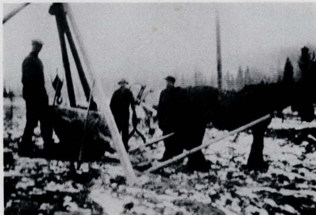
Fra Løvås, 1938, tre av veteranene ved stubbryteren, f.v.: Petter Mathisen, Peder Trondsen og Ole Rugsveen. Hesten var lånt i Simenstua fra Johannes Rugsveen. Stubbryteren var det viktigste redskapet ved sida av hakke, spade og øks. Først omkring 1955 begynte de å bryte jord med bulldozer. (39630).
