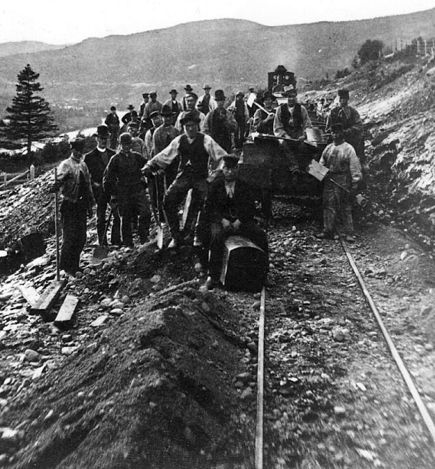
Bygging av Rørosbanen, mye arbeid foregikk for hand. Arbeidsstokken ved Drøiliene i Haltdalen, 1876. (8696, Norsk jernbanemuseums samling).
