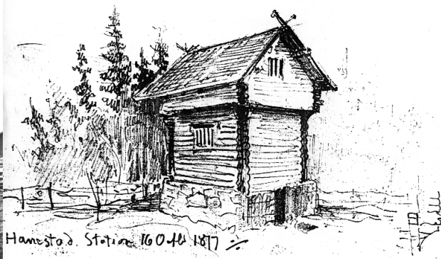
Hanestad stasjon, fjøs 1877. Frå opningsferda av Rørosbanen festa jernbanedirektør von Hanno mange av sine inntrykk på papiret. Eit av desse var fjøset ved Hanestad stasjon.
