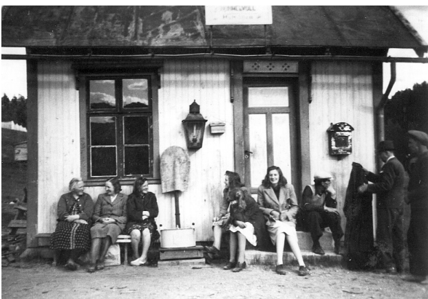
Håmåvoll stoppested, oppretta 15.01. 1916, nedlagt 31.05.1987. Os kommune har i dag sett huset i stand som eit verneobjekt. (40605)
