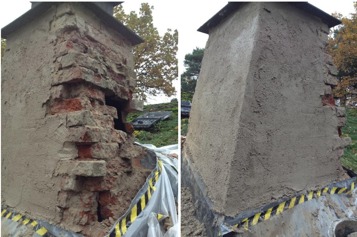
T.v. och T.h. Under putsningsarbetet byttes teglet ut vartefter.
