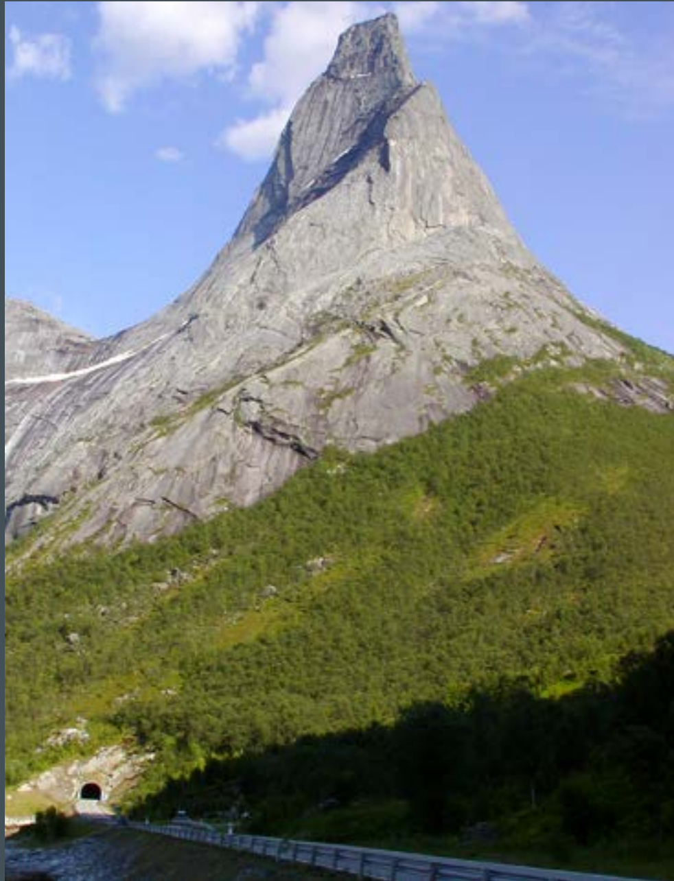
Stetind tunnel i vill Norlandsnatur. Tunnelene har gjort det mulig å ta seg frem der det før var stengt. (Foto Lars Arne Bakken)
