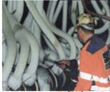
Frysing før tunneldriving i Oslofjordtunnelen. (Foto Eirik Øvstedal)
