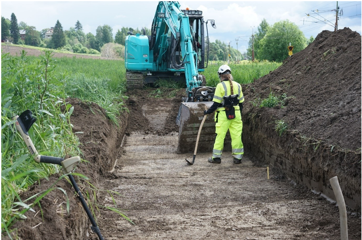
Figur 9. Arbetsbild schakt 17. Foto från väst.
