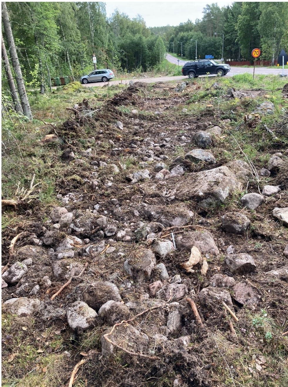
Fig. 6. Schakt 2–4, foto från V.
