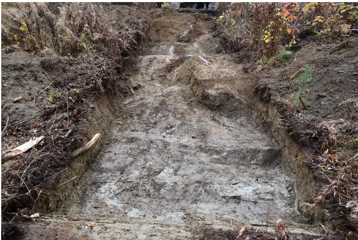
Figur 7. Schakt 3. Foto från öster.
