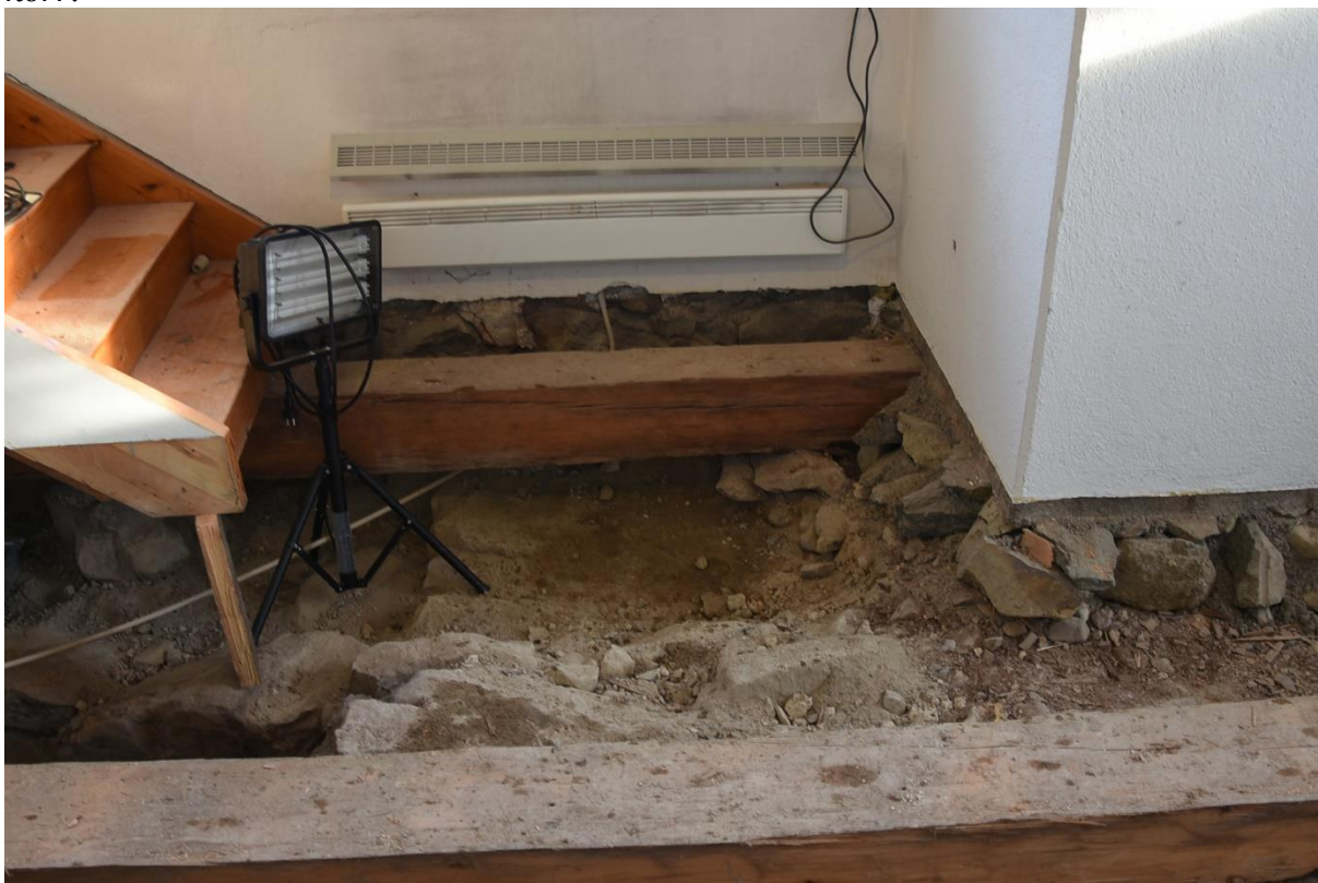
Figur 8. Sakristians östra delar efter rensning. I bildens nedre del syns stenpackningen till källaren. Till höger i bild syns arkivrummet nordvästra hörn. Foto från väster.
