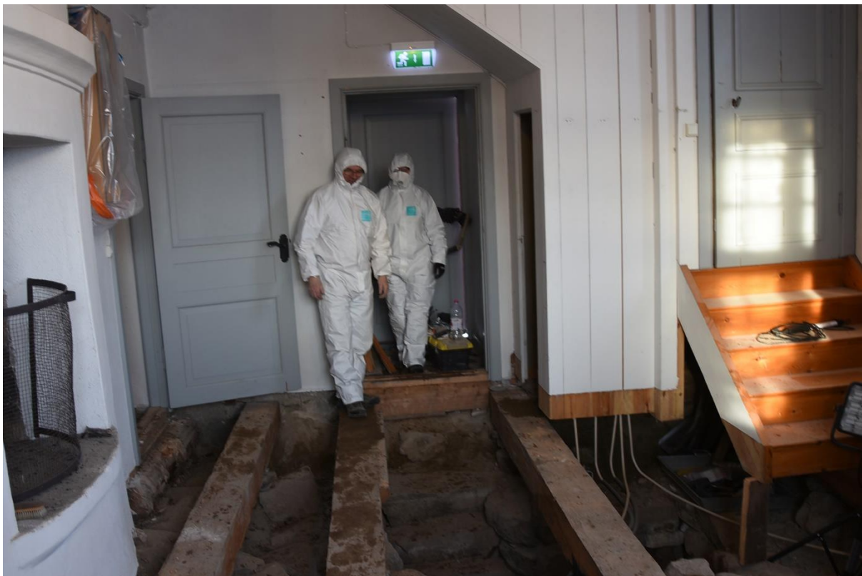
Figur 9. Sakristians norra delar efter rensning. I bildens nedre del syns trappen till källaren. I bildens högra del syns trappen upp till övervåningen. Foto från söder.
