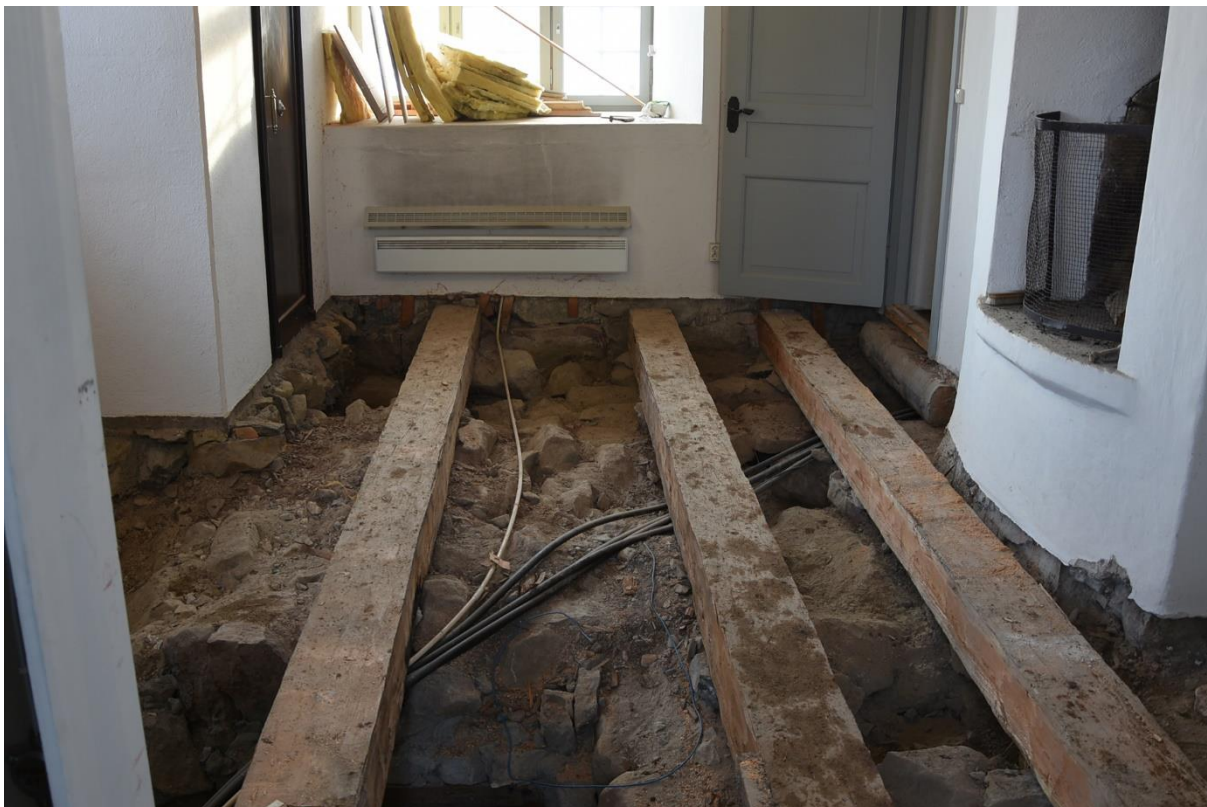
Figur 7. Sakristians södra delar efter rensning. I bildens nedre del syns källaren. Foto från norr.
