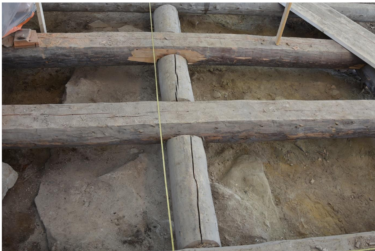
Figur 12. Delar av den norra grundmuren framgrävd. Foto från väster.
