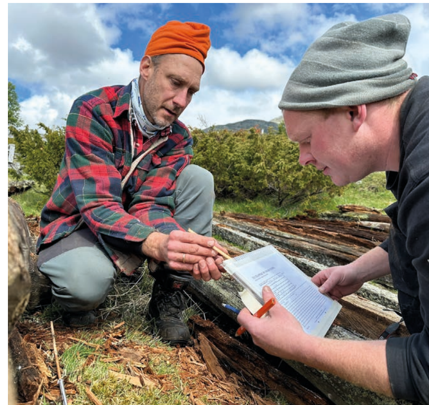
Bygningsvernrådsgjevar Håvard Syse (til venstre) og John Ola Selsjord på befaring. Foto: Knut Aastad Bråten.
